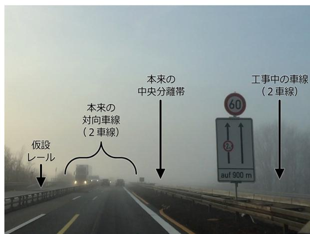
(写真2) 工事中の Autobahn。ドライブレコーダーの記録から抜粋。片道2車線で、片道が工事中(工事している様子もほとんど見たことがない)だが、対向車線に仮設レールを引いて、オレンジ色の一時道路標識で片道2車線を維持している(白い道路標識が本来の対向車線の道路標識)。右の標識によると車線幅が2mになっている(日本の通常の高速度路なら3.5m)。
